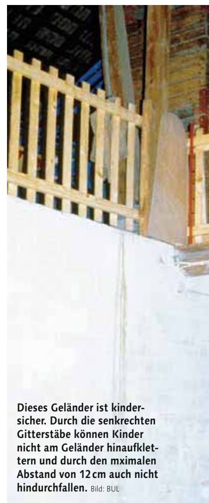
Dieses Geländer entspricht den Anforderungen der Arbeitssicherheit. Bei solchen Lagerböden muss darauf geachtet werden, dass Kinder keinen Zutritt gewährt wird, zum Beispiel mit einem Türchen beim Aufgang. Bild: BUL
